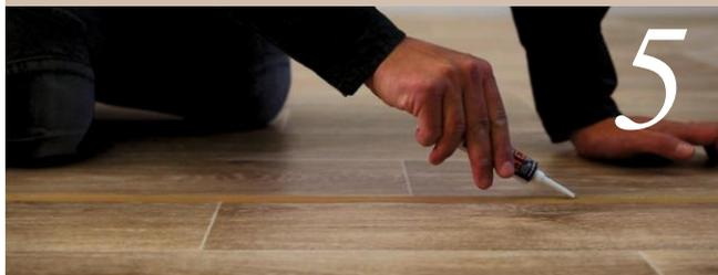
Retire la cinta adhesiva y limpie los restos de líquido de soldadura con gasolina de quemar. Evite caminar sobre la articulación durante 24 horas.
