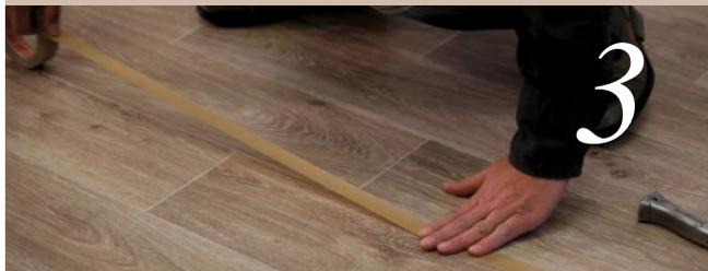
Divida la cinta adhesiva en la junta con una cuchilla de gancho.
