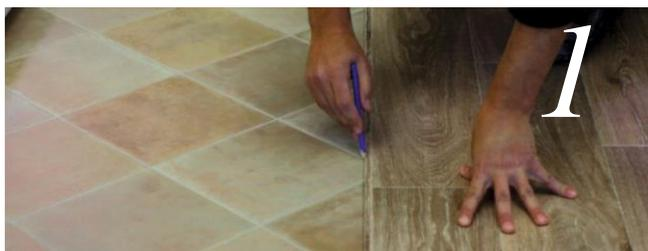
Coloque un adhesivo de doble cara no migrante o cinta adhesiva bajo el precinto antes de realizar el doble corte.
