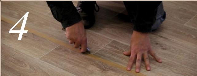
Introduzca el extremo de la boquilla en la junta y trabaje hacia atrás, inyectando lentamente el líquido hasta que rebose en la superficie sobre la cinta adhesiva de papel. Dejar actuar el líquido de soldadura durante más de 1 minuto.
